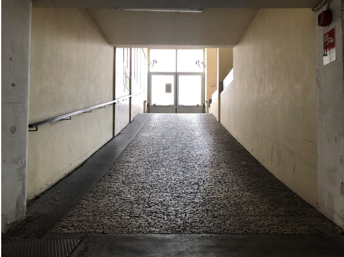
Foto 05 - Rampa di discesa al piano interrato
