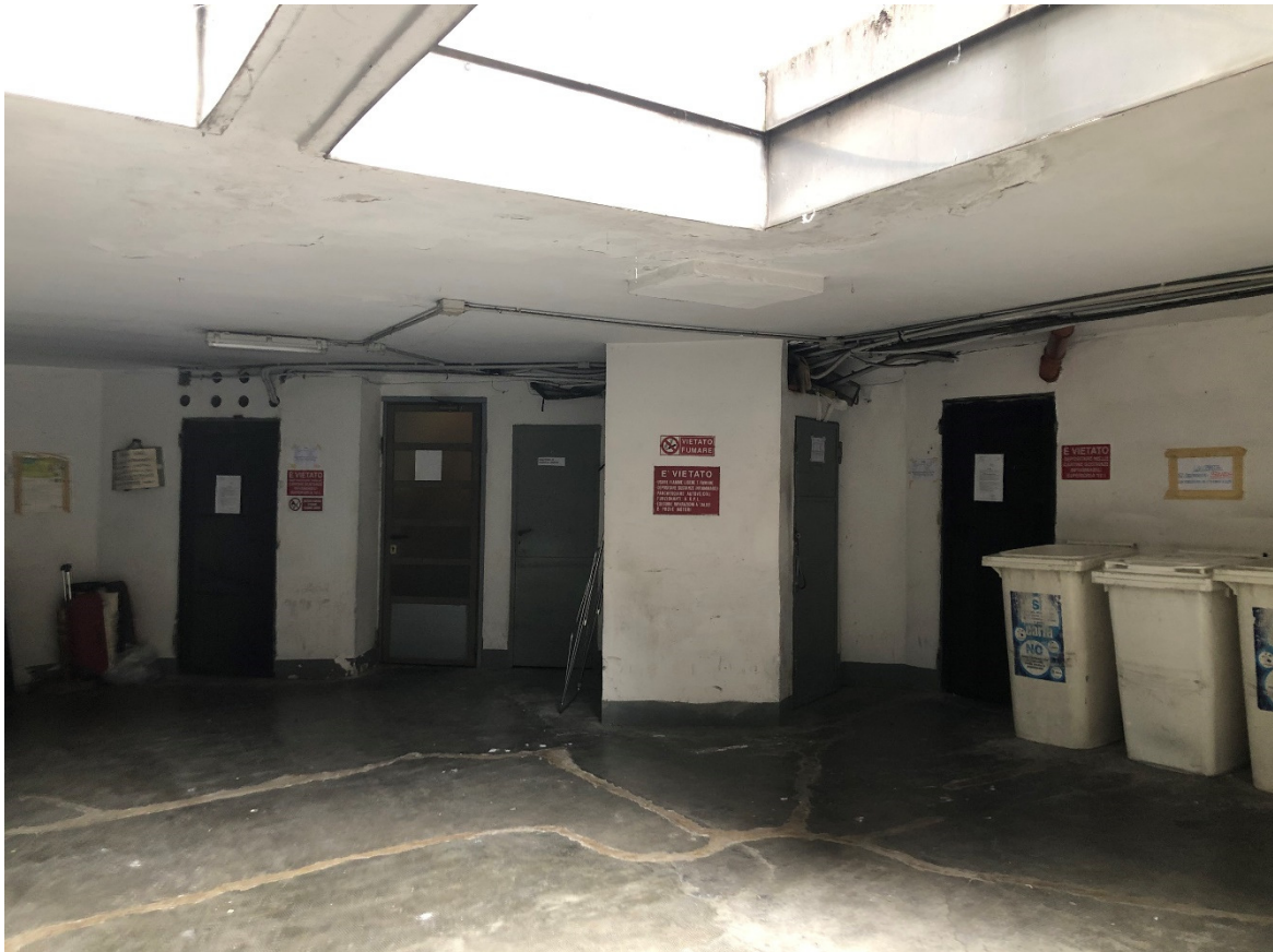
Foto 06 - Corsello comune al piano interrato
