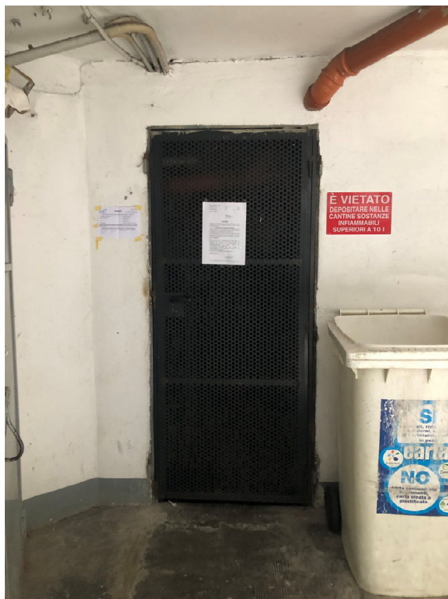
Foto 07 - Accesso alle cantine
