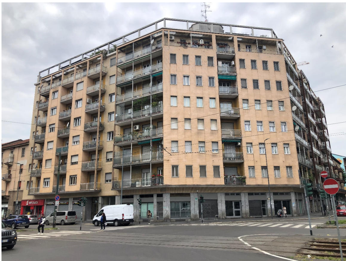
Foto 02 - Il fabbricato su via Giambellino
