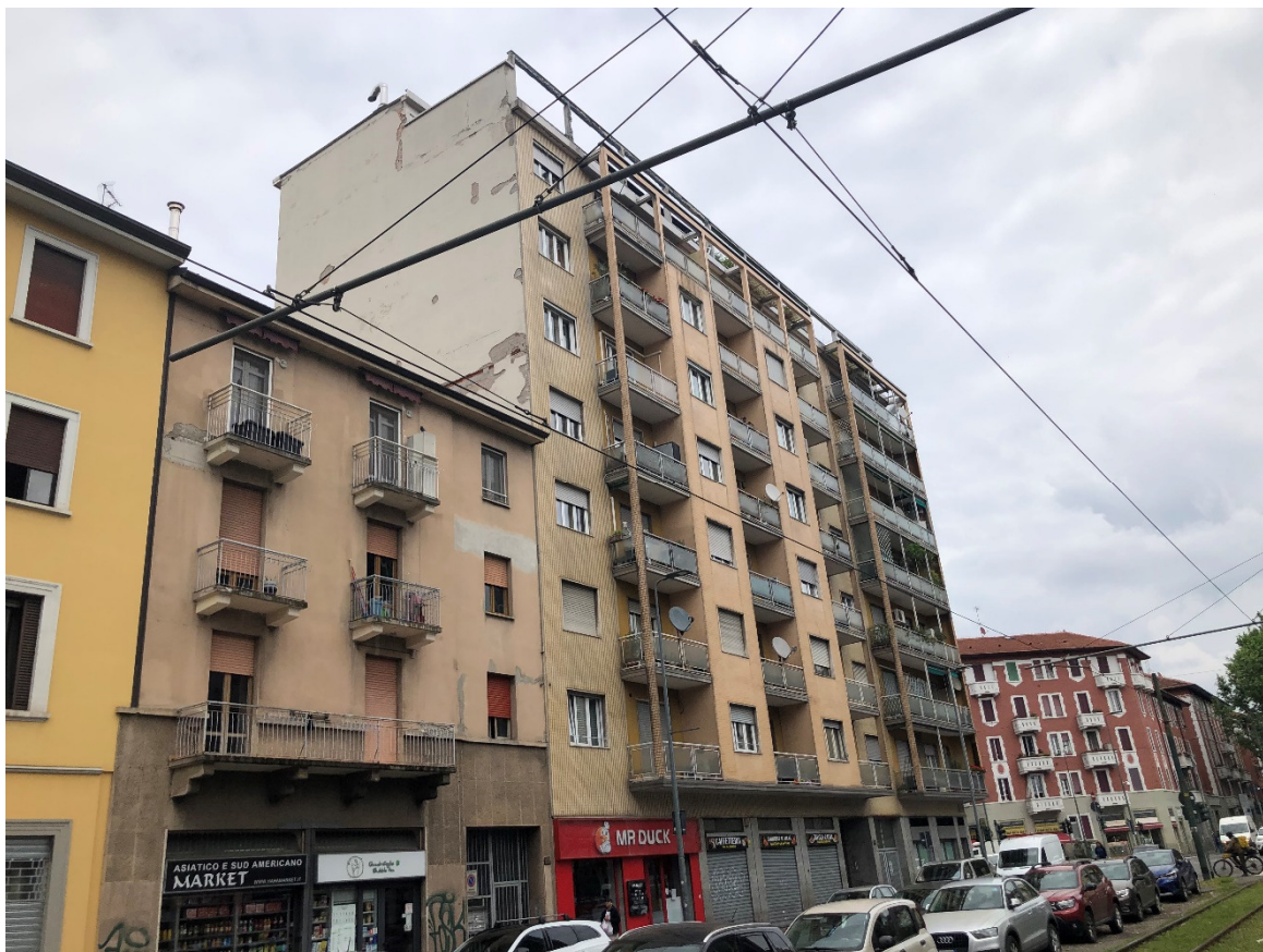
Foto 01 - Il fabbricato su via Giambellino
